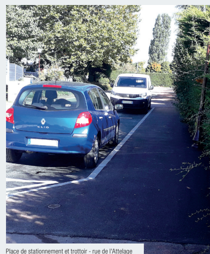
Place de stationnement et trottoir - rue de l'Attelage
