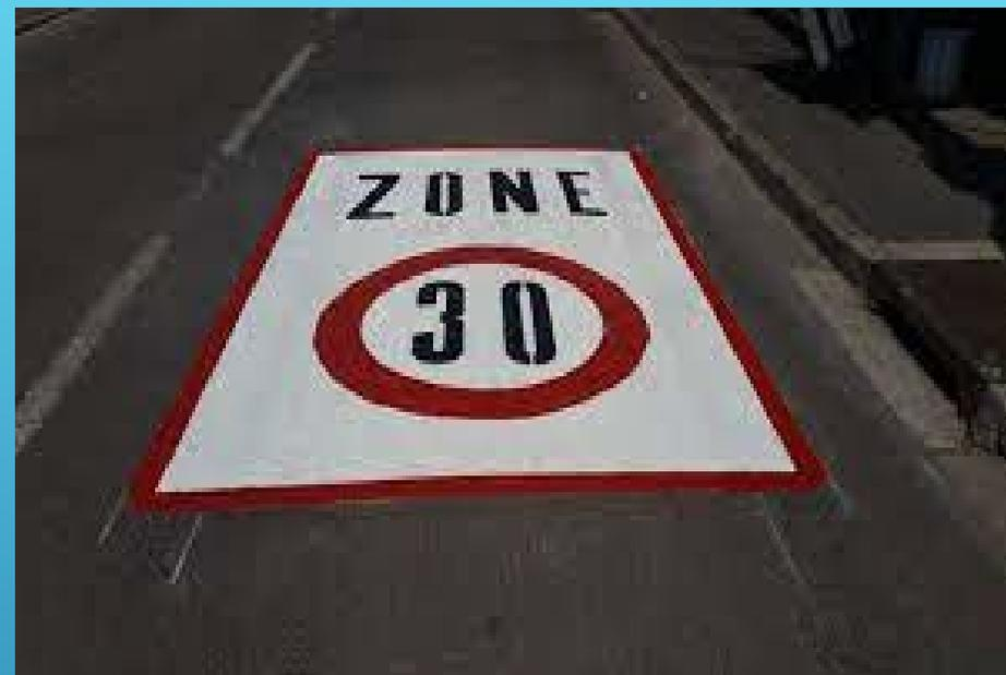
Pose d'une signalisation au sol indiquant la limitation à 30 Km/h à l'entrée des voies des zones 30.
