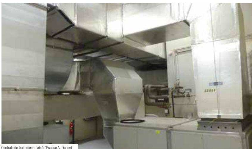
Centrale de traitement d'air à l'Espace A. Daudet
