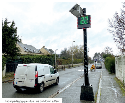
Radar pédagogique situé Rue du Moulin à Vent
